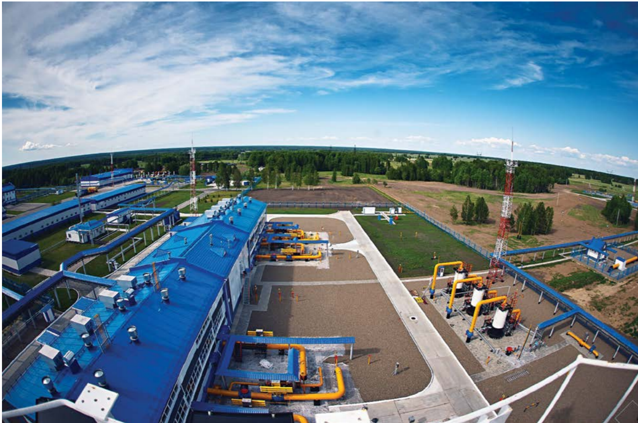
ЭГПА 4,0 МВт на КС «Володино» магистрального газопровода «Парабель-Кузбасс»
