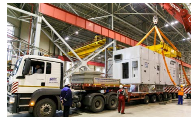
Транспортировка ГТУ Т16 в состоянии полной заводской готовности
