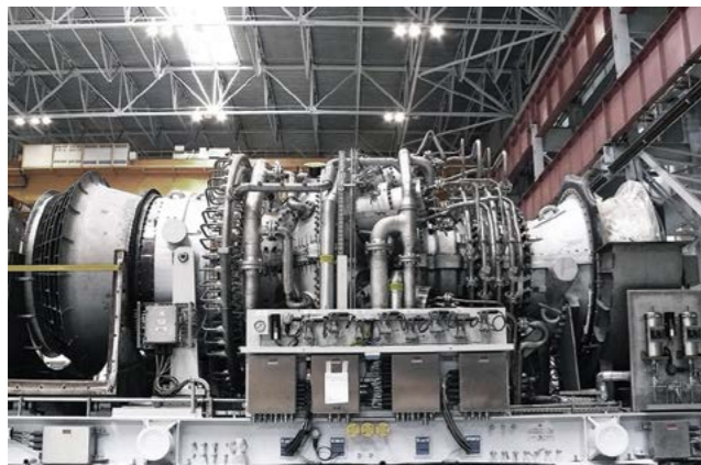
ГТУ 32 МВт на производственной площадке «Невский Завод»
