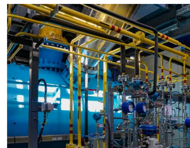
Центробежный компрессор смешанного хладагента K 905-71-1C на заводе СПГ «Криогаз - Высоцк»
