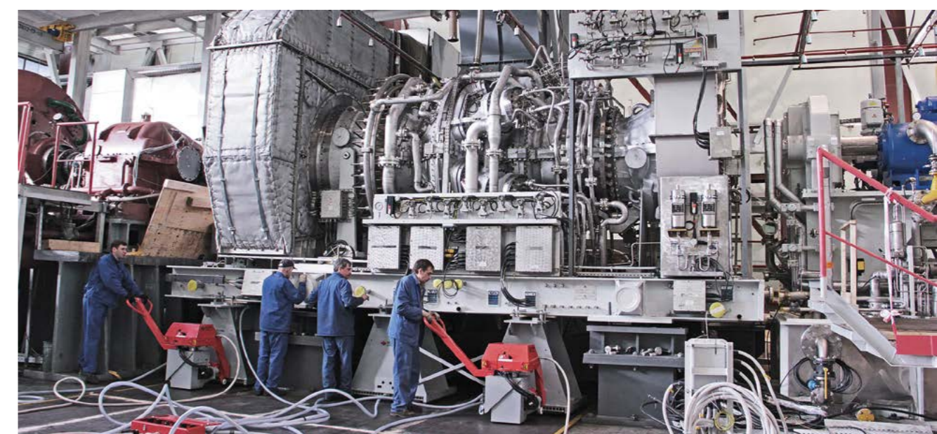
Установка ГТУ Т32 на испытательный стенд на производственной площадке «Невский Завод»
