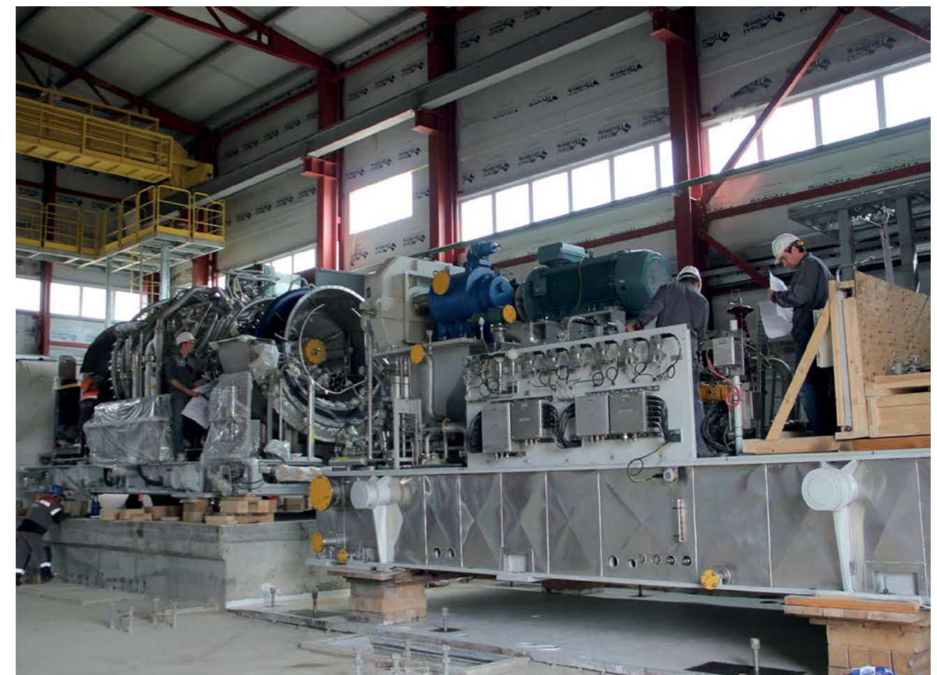
Монтаж ГПА-32 «Ладога» на КС «Русская»
