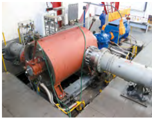
Испытательный стенд центробежных компрессоров
